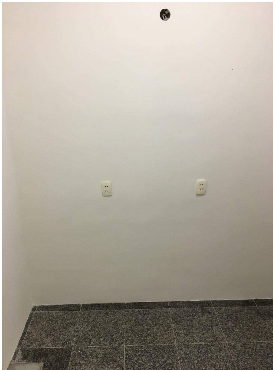
Figura 106 – Resultado final do escritório após a pintura das paredes
