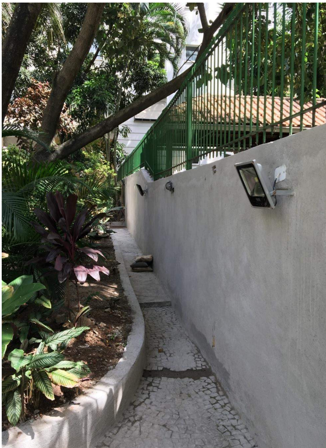
Figura 101 – Detalhe para a conclusão do serviço de regularização do muro do Condomínio
