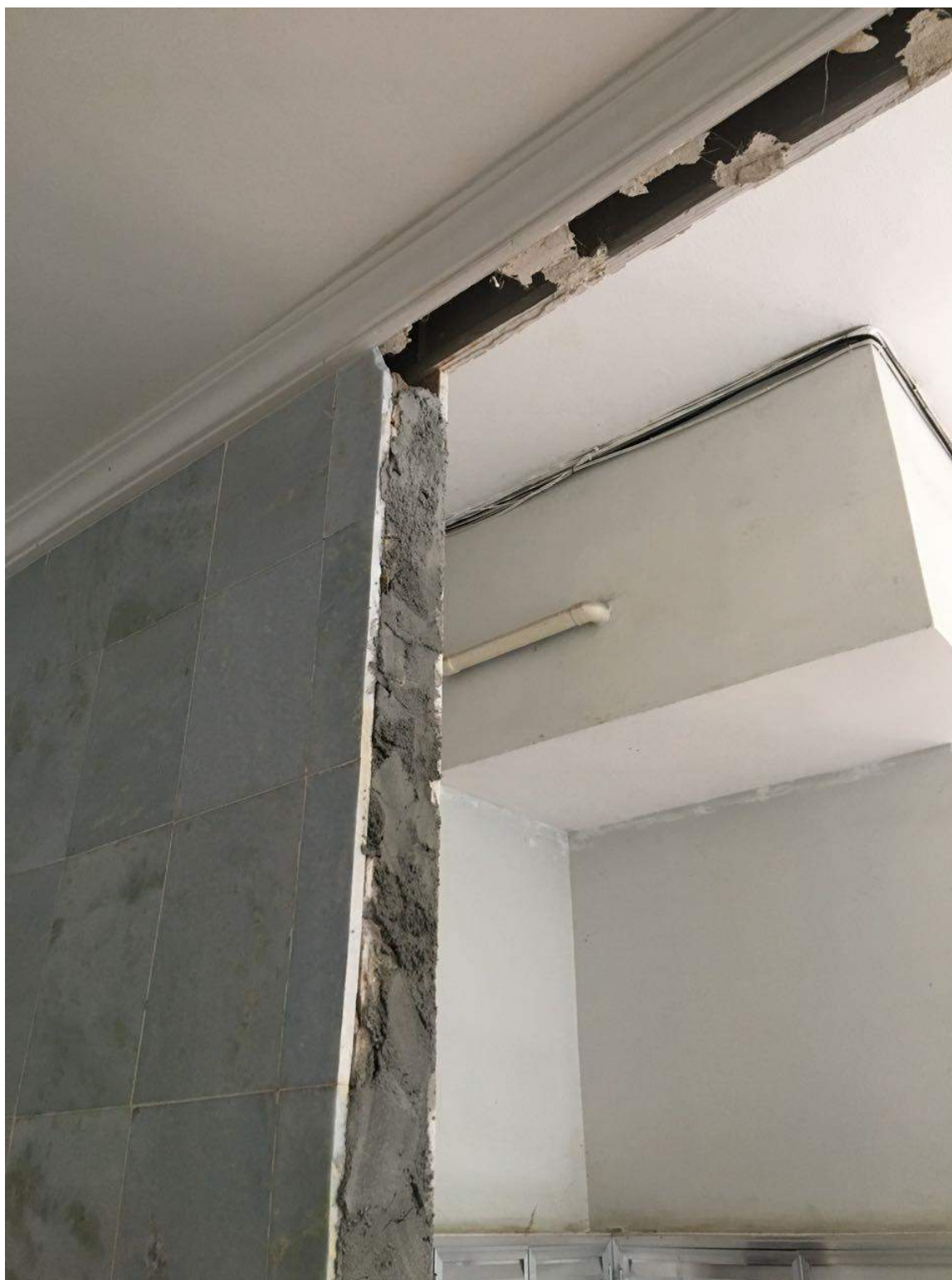
Figura 54 – Detalhe para a abertura realizada no vão de passagem
