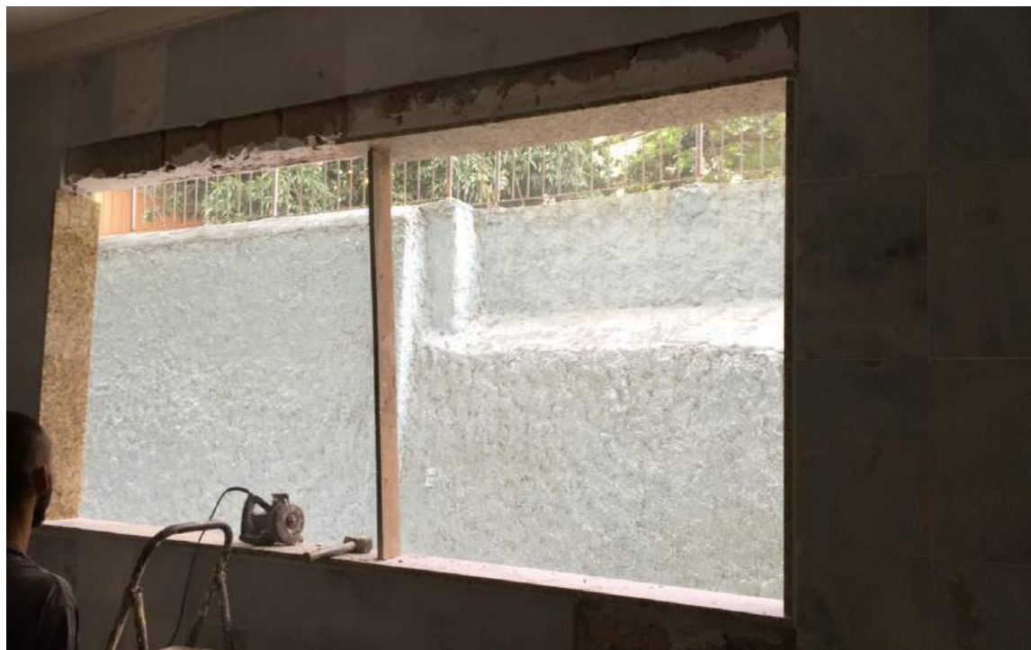
Figura 46 – Realização do escoramento para a colocação do mármore
