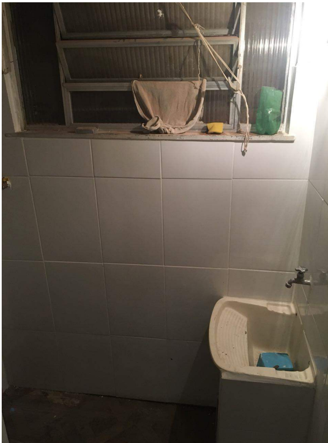
Figura 136 – Conclusão da colocação do novo revestimento no banheiro
