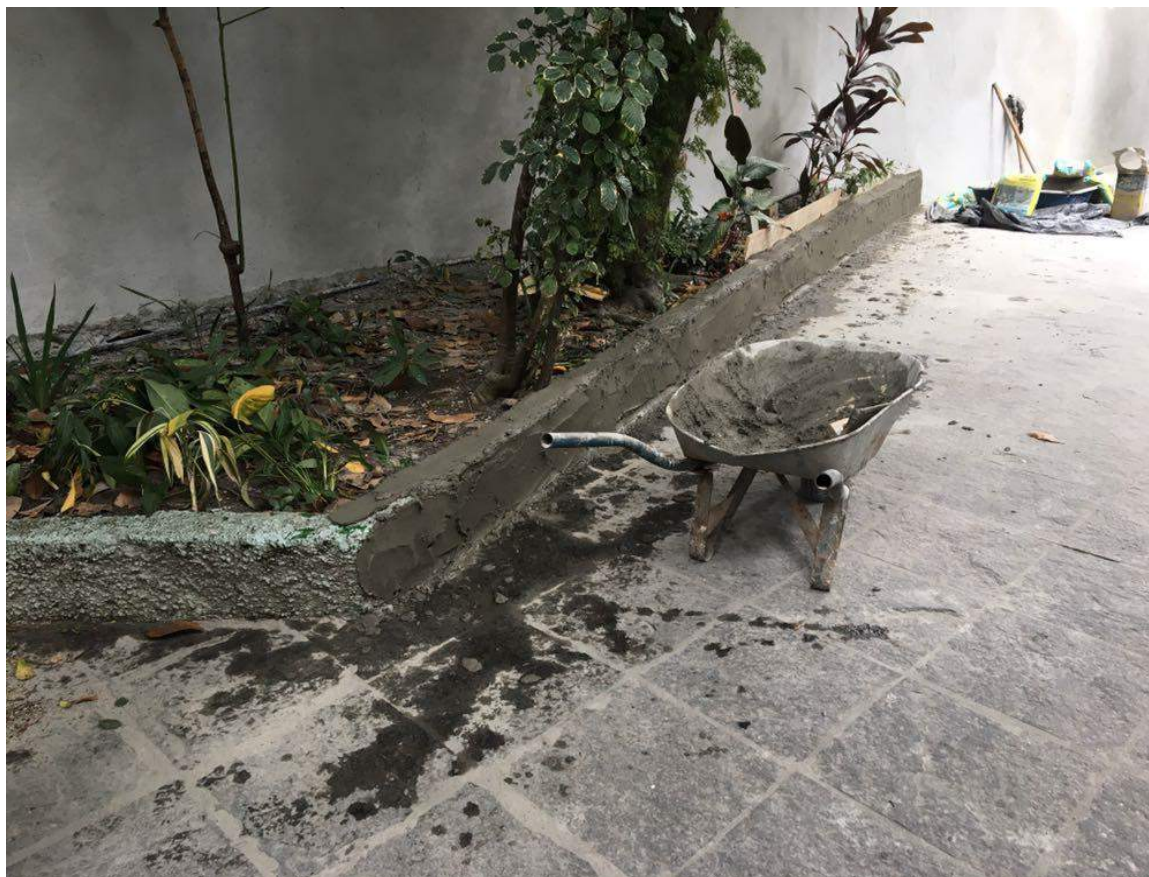
Figura 84 - Começando o serviço de regularização das muretas e muro
