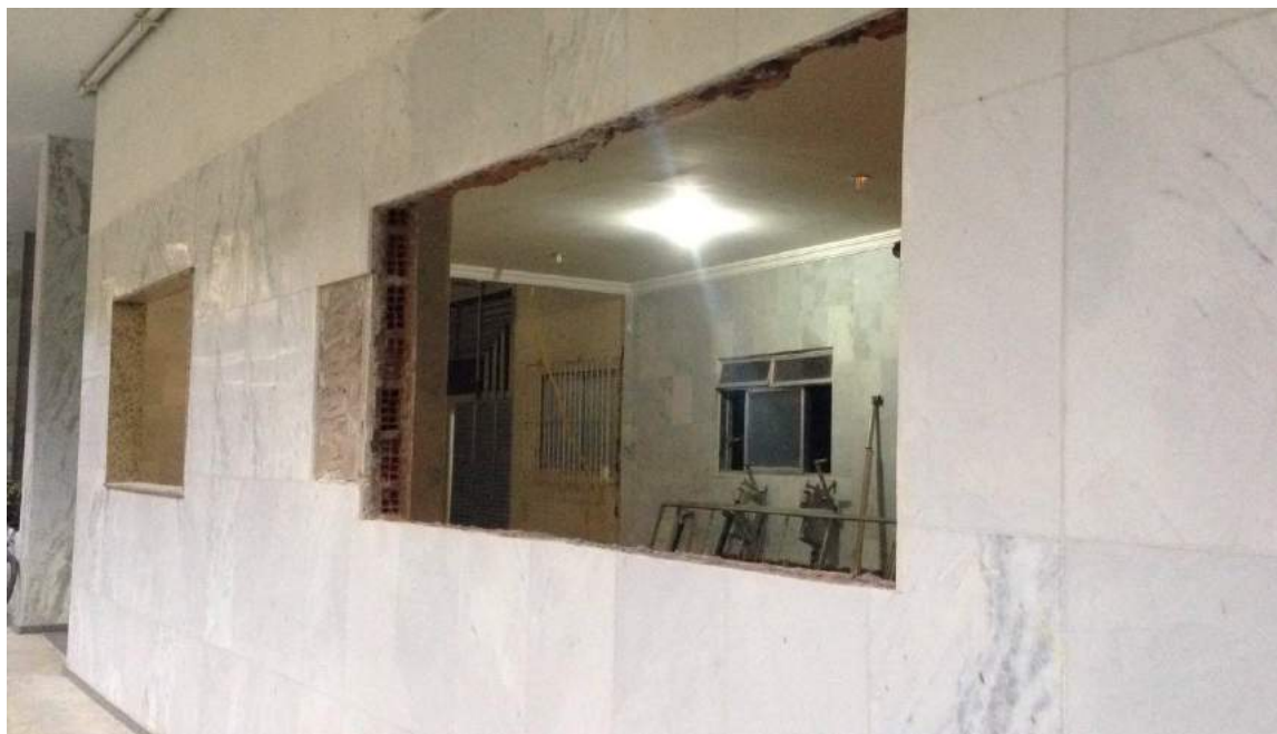
Figura 42 – Retirada da esquadria e realização de uma nova abertura
