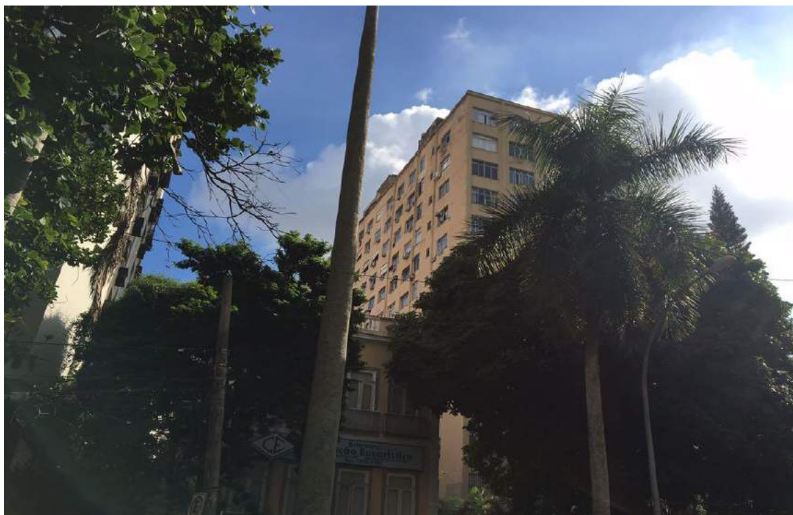
Figura 1 – Fachada frontal e lateral direita antes do início do serviço da Construtora Cernigoi
