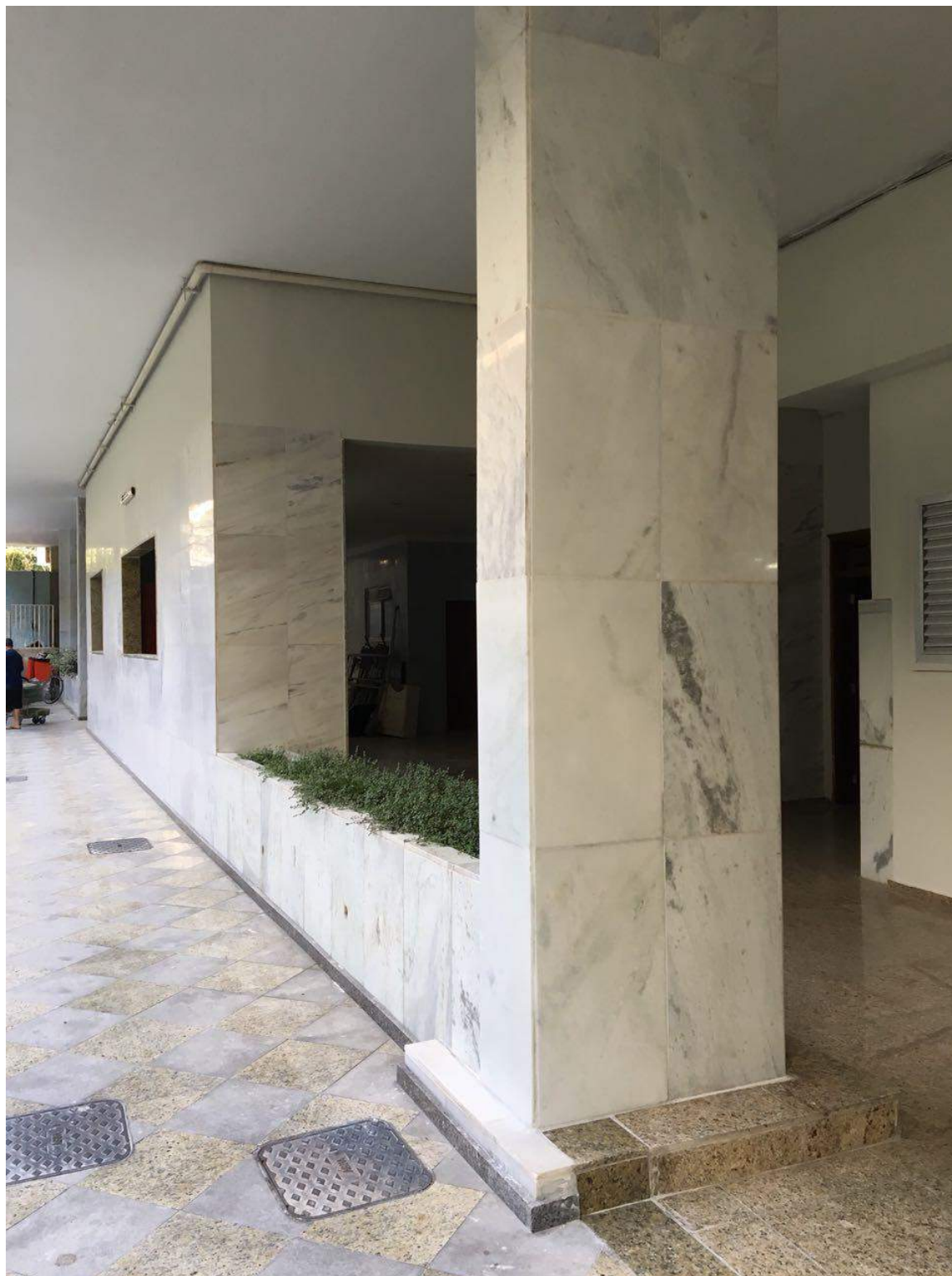
Figura 76 – Detalhe da reposição dos mármore branco da coluna e granito no piso
