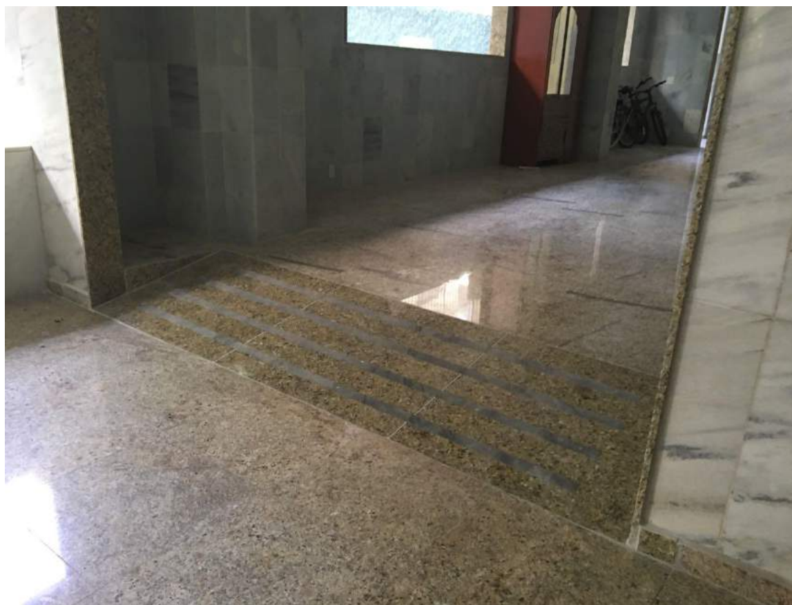
Figura 68 – Detalhe para a colocação de faixas antiderrapantes na rampa de passagem
