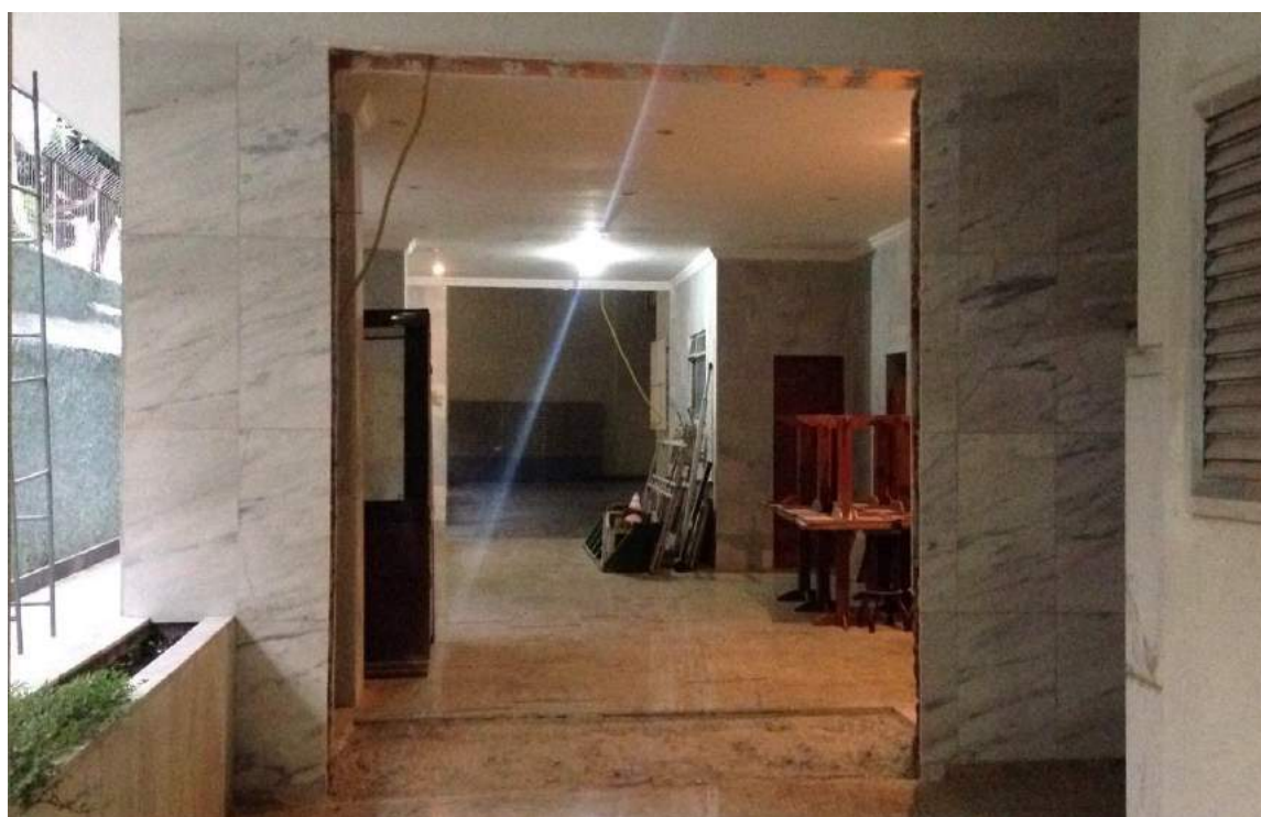
Figura 53- Abertura dos vãos de passagem dos moradores
