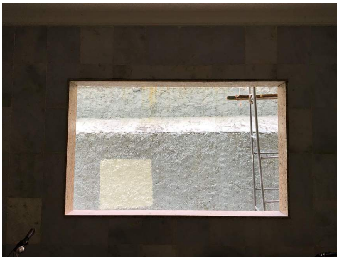
Figura 48 – Conclusão da moldura em mármore das esquadrias das aberturas laterais
