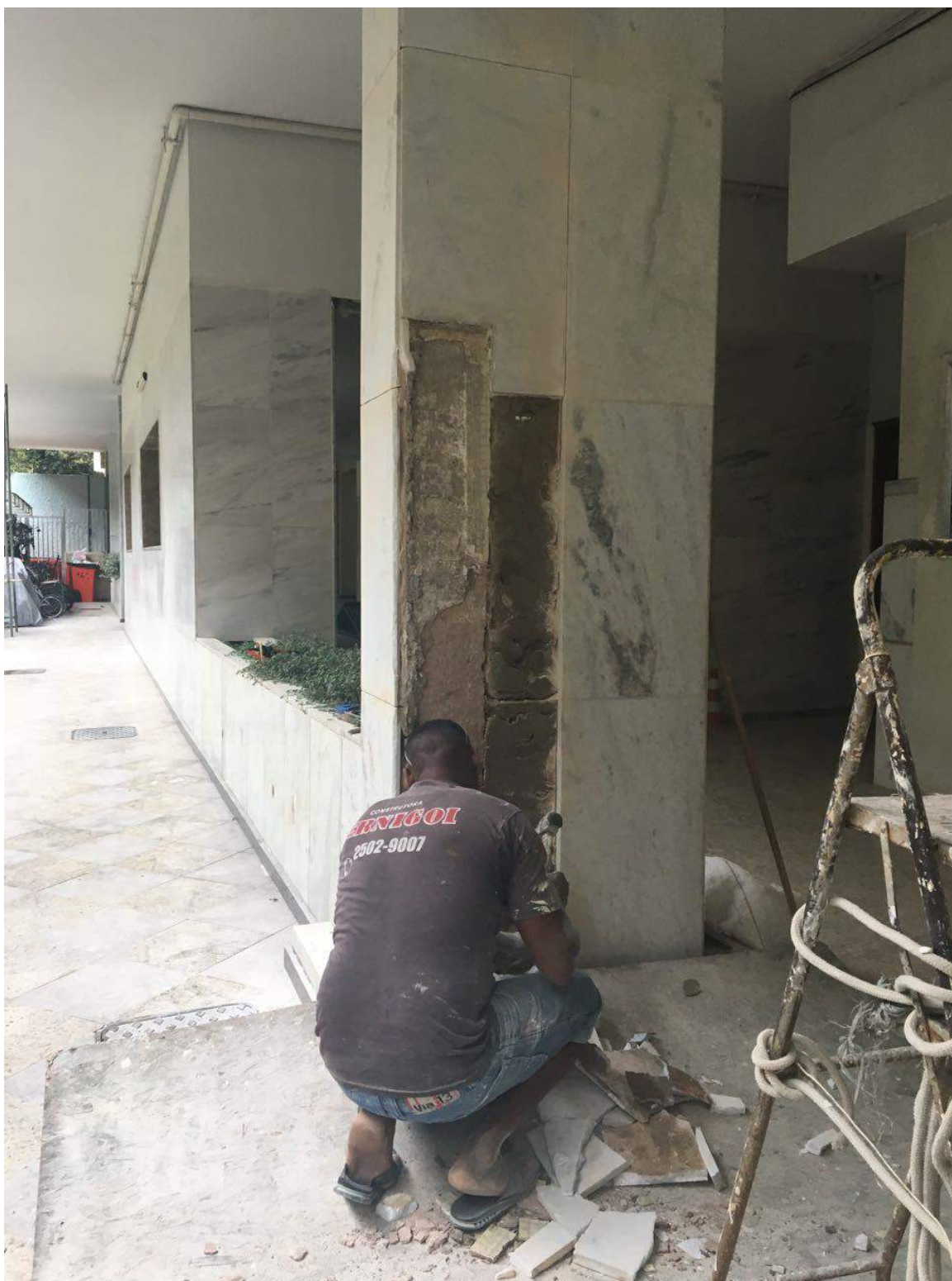
Figura 74 – Início da retirada das pedras de mármore da entrada
