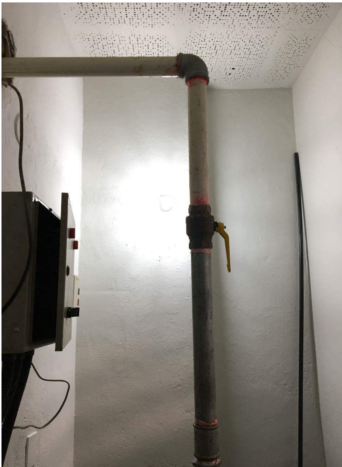
Figura 125 - Conclusão do serviço de Recomposição do revestimento e pintura das paredes da casa de bomba de recalque
