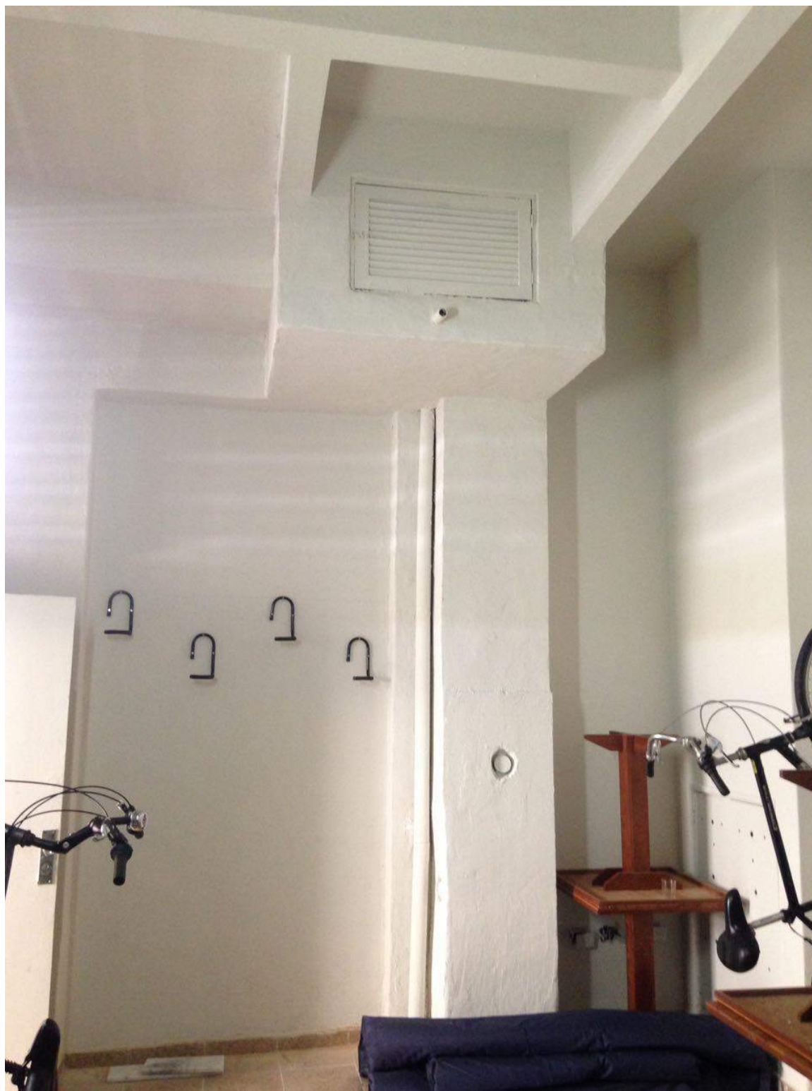
Figura 164 – Conclusão da reforma da casa de porteiro do Condomínio do Edifício Solange
