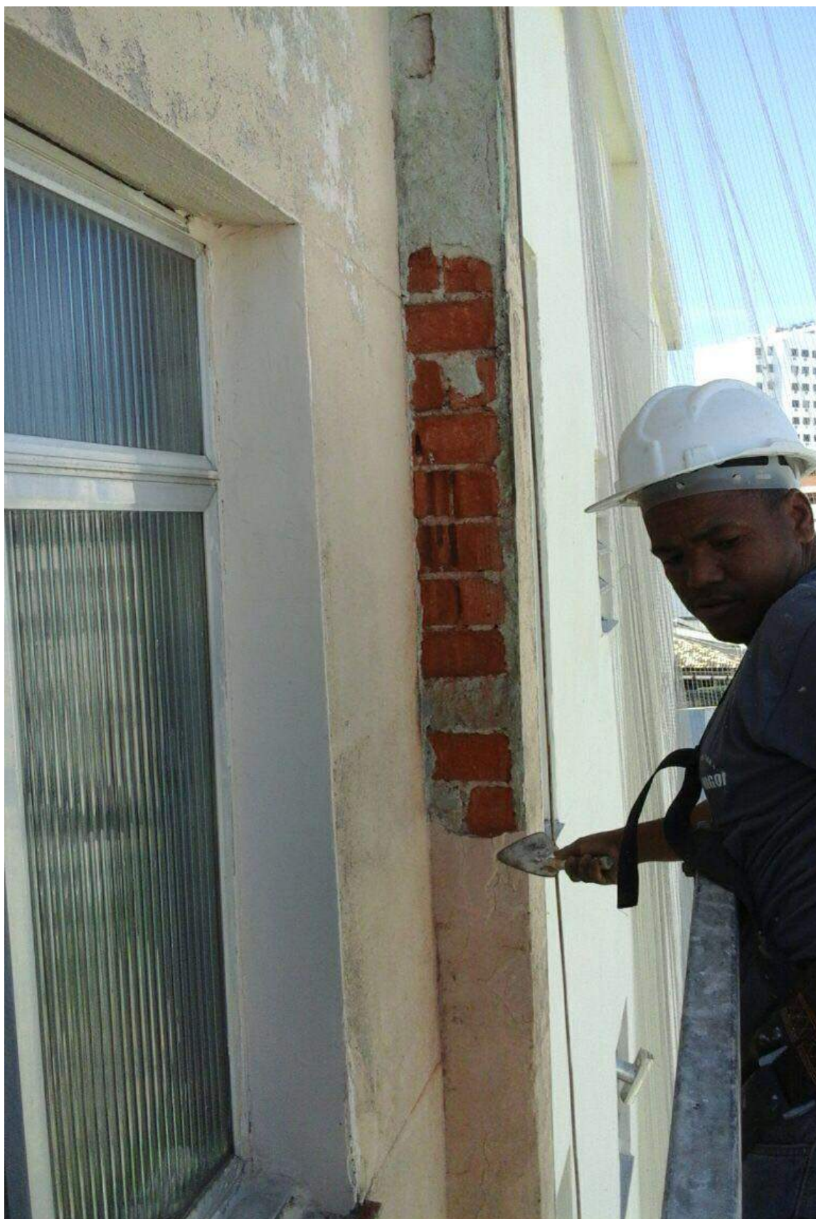
Figura 5 – Inicialização da retirada do revestimento mal aderido
