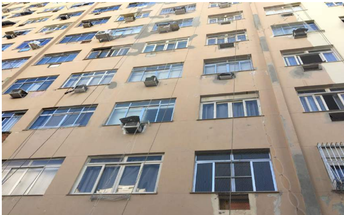
Figura 36 – Recomposição do revestimento em argamassa realizada na fachada lateral direita
