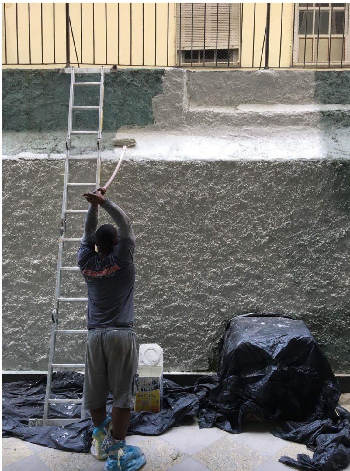
Figura 115 – Começando o serviço de pintura do muro do condomínio
