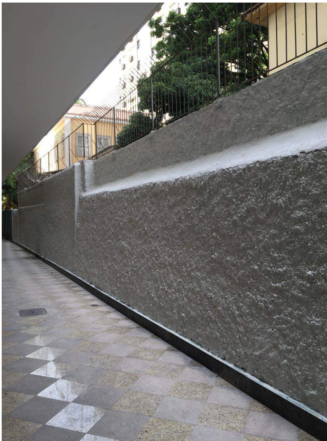
Figura 117 – Pintura do muro lateral do condomínio concluído
