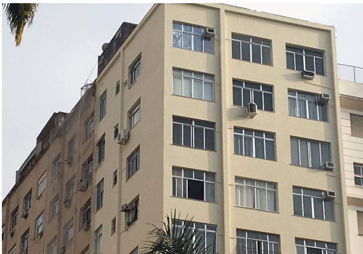
Figura 32 - Conclusão fachada frontal e 1ª seção da lateral direita
