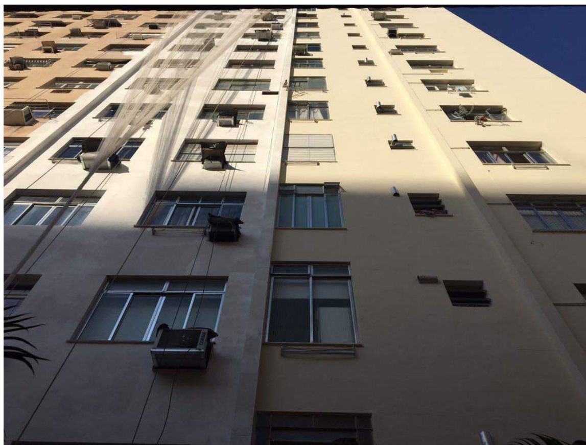
Figura 28 – Detalhe para a primeira seção da fachada lateral direita concluída
