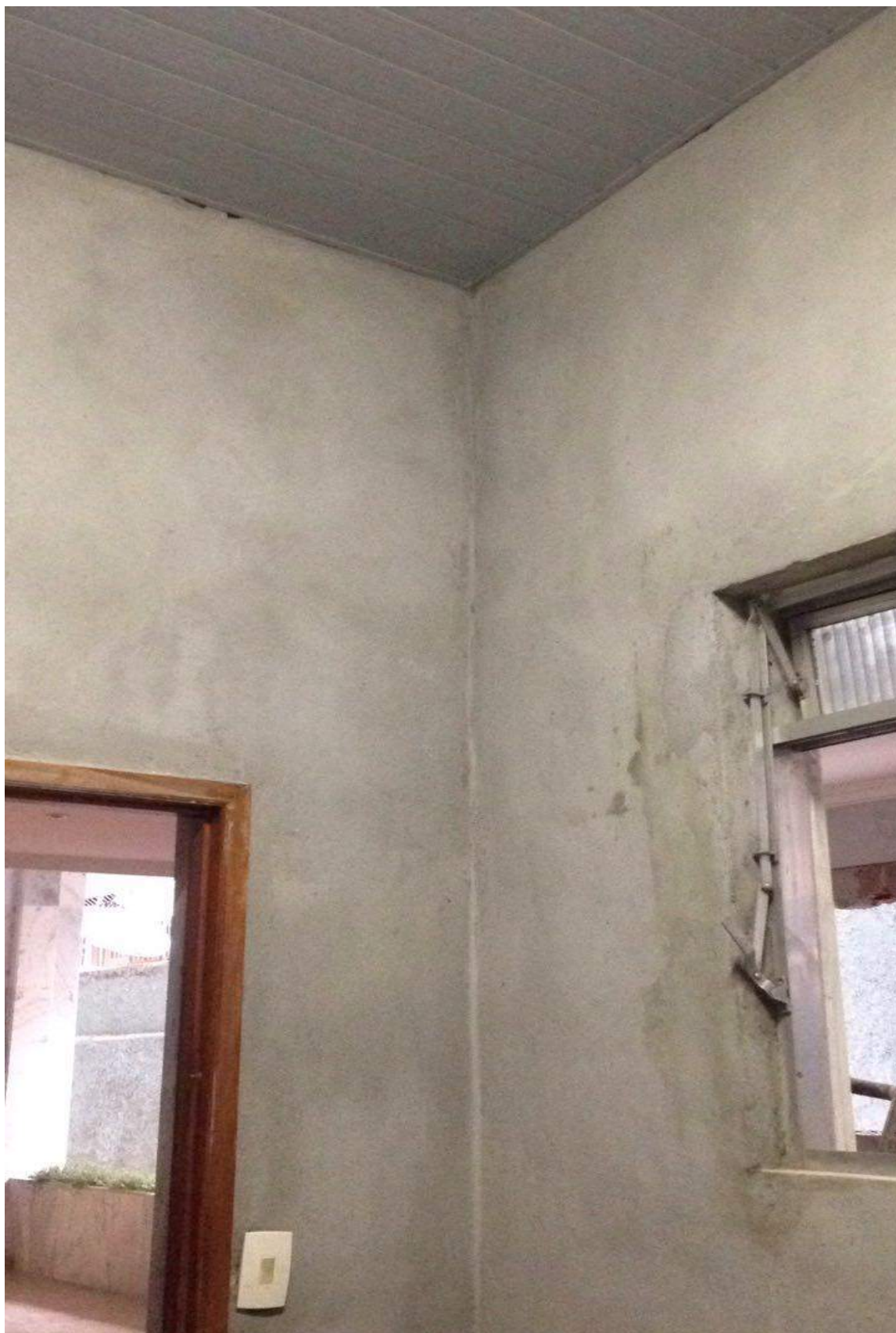
Figura 102 – Realização da reforma da sala de Administração do Condomínio
