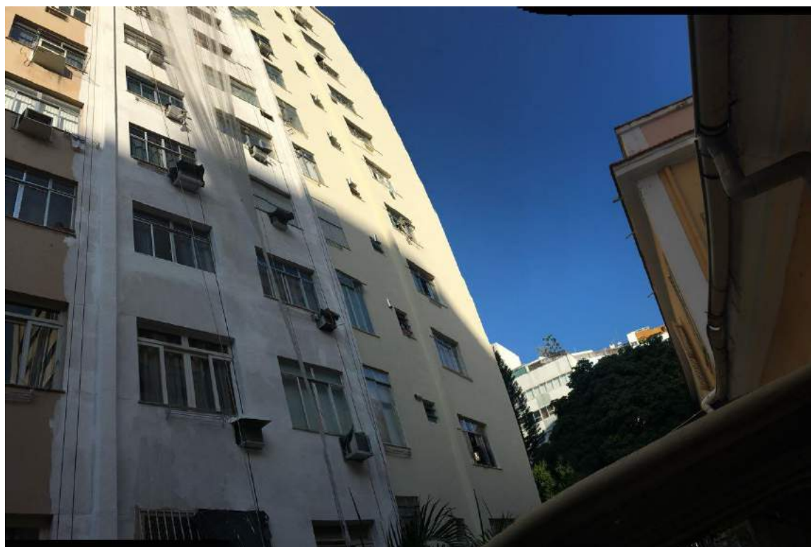
Figura 30 – Detalhe para a aplicação de selador na segunda seção do edifício concluída
