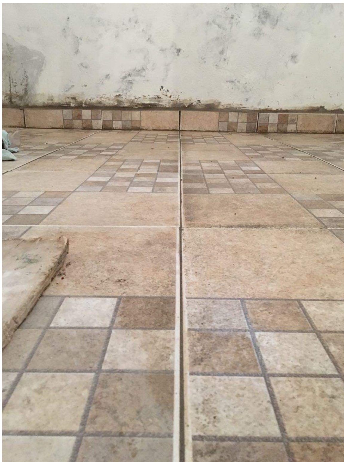
Figura 157 – Serviço de colocação do novo piso
