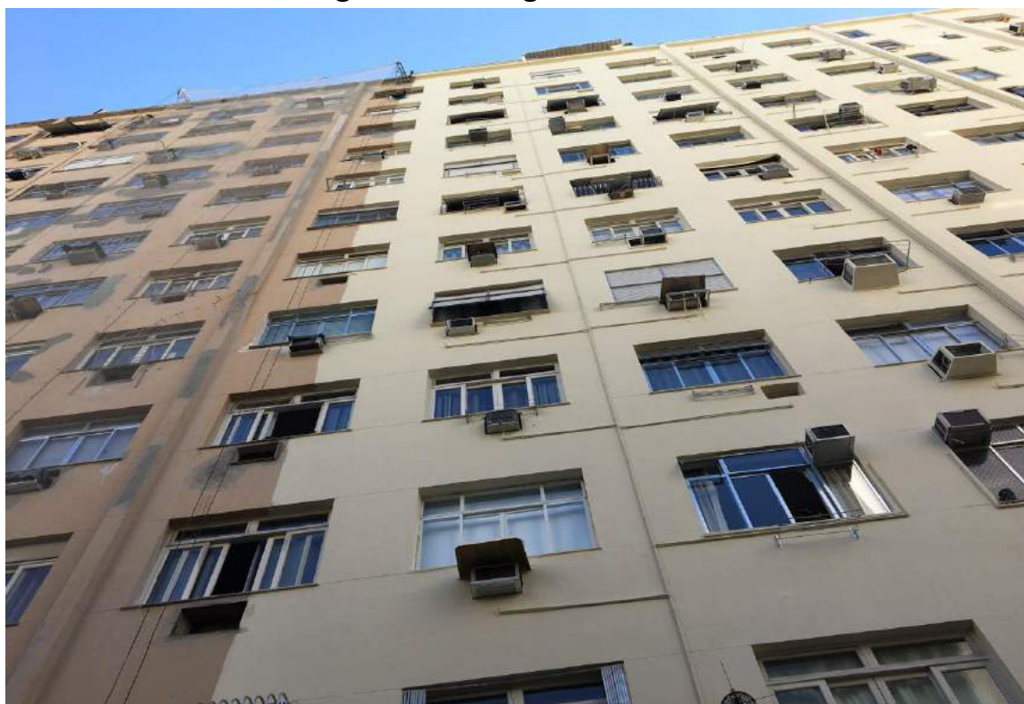
Figura 35 – Detalhe dos drenos já instalados 2ª seção da fach. Lat direita
