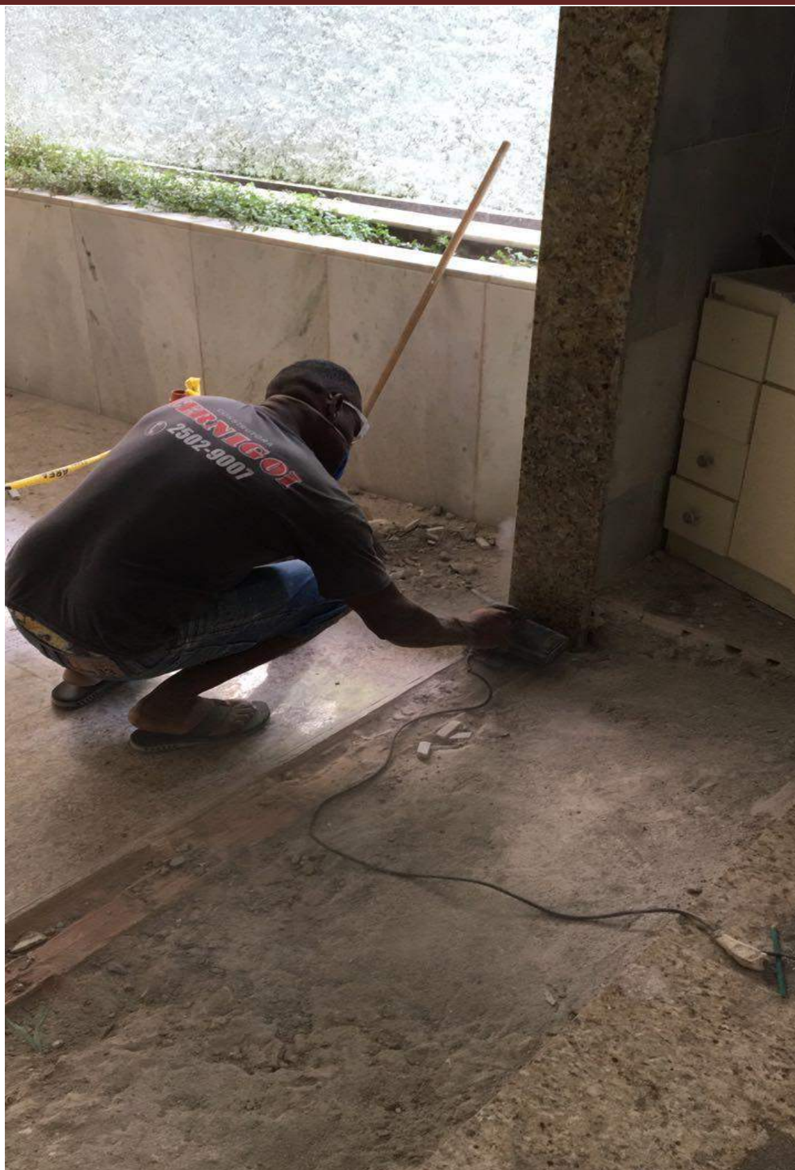
Figura 62 – Iniciando o serviço de colocação da pedra de mármore para a rampa
