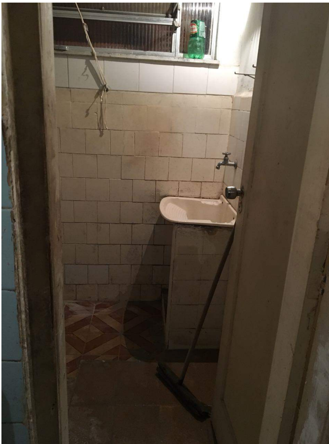
Figura 128 – Estado anterior do banheiro da casa de porteiro antes do serviço de reforma do mesmo
