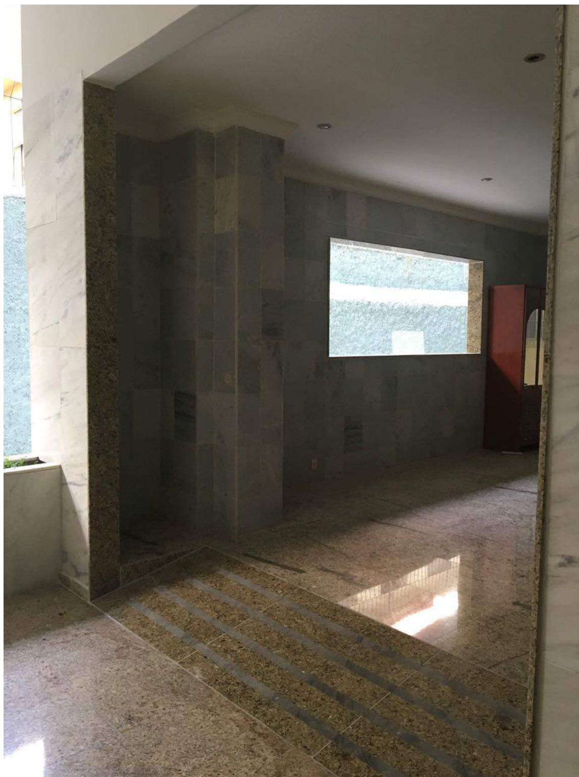
Figura 69 – Conclusão do vão de passagem
