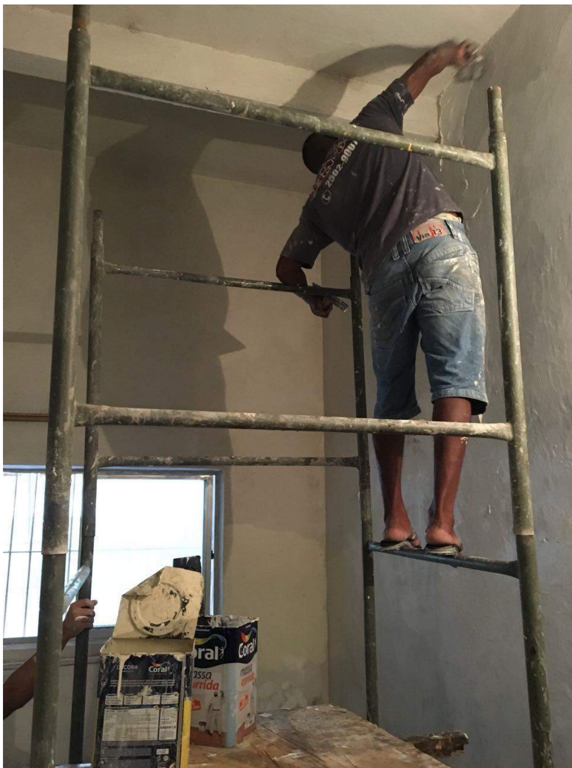
Figura 154 – Realização da reforma no quarto da casa de porteiro
