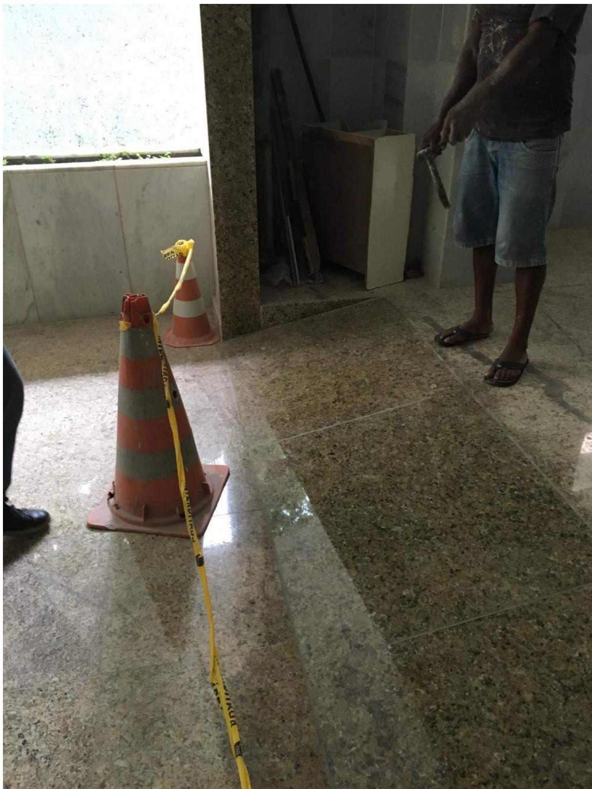
Figura 65 – Conclusão da rampa do vão de passagem
