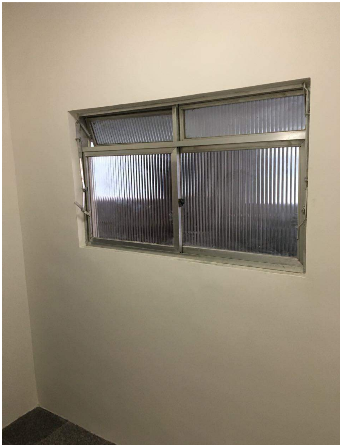
Figura 107 – Detalhe para o acabamento da esquadria após o serviço
