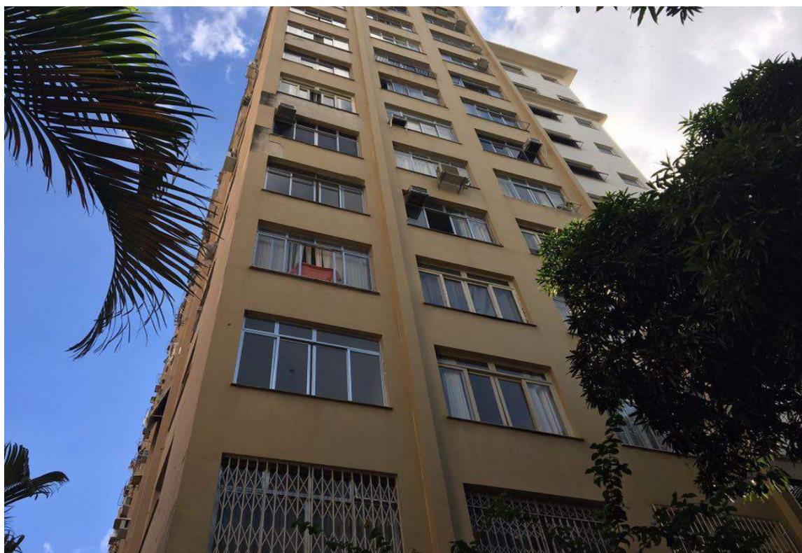
Figura 2 – Imagem adicional com detalhe para a fachada frontal do Condomínio do Edifício Solange
