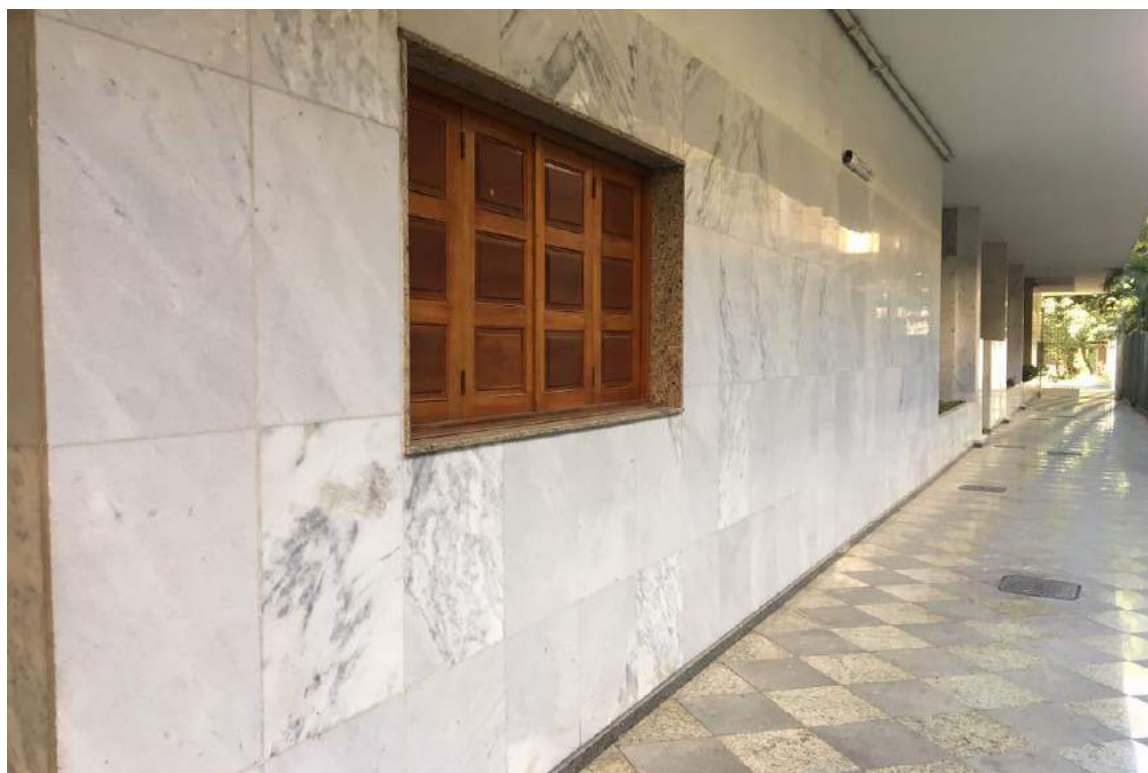
Figura 41 – Vista inicial da área lateral da passagem nível térreo
