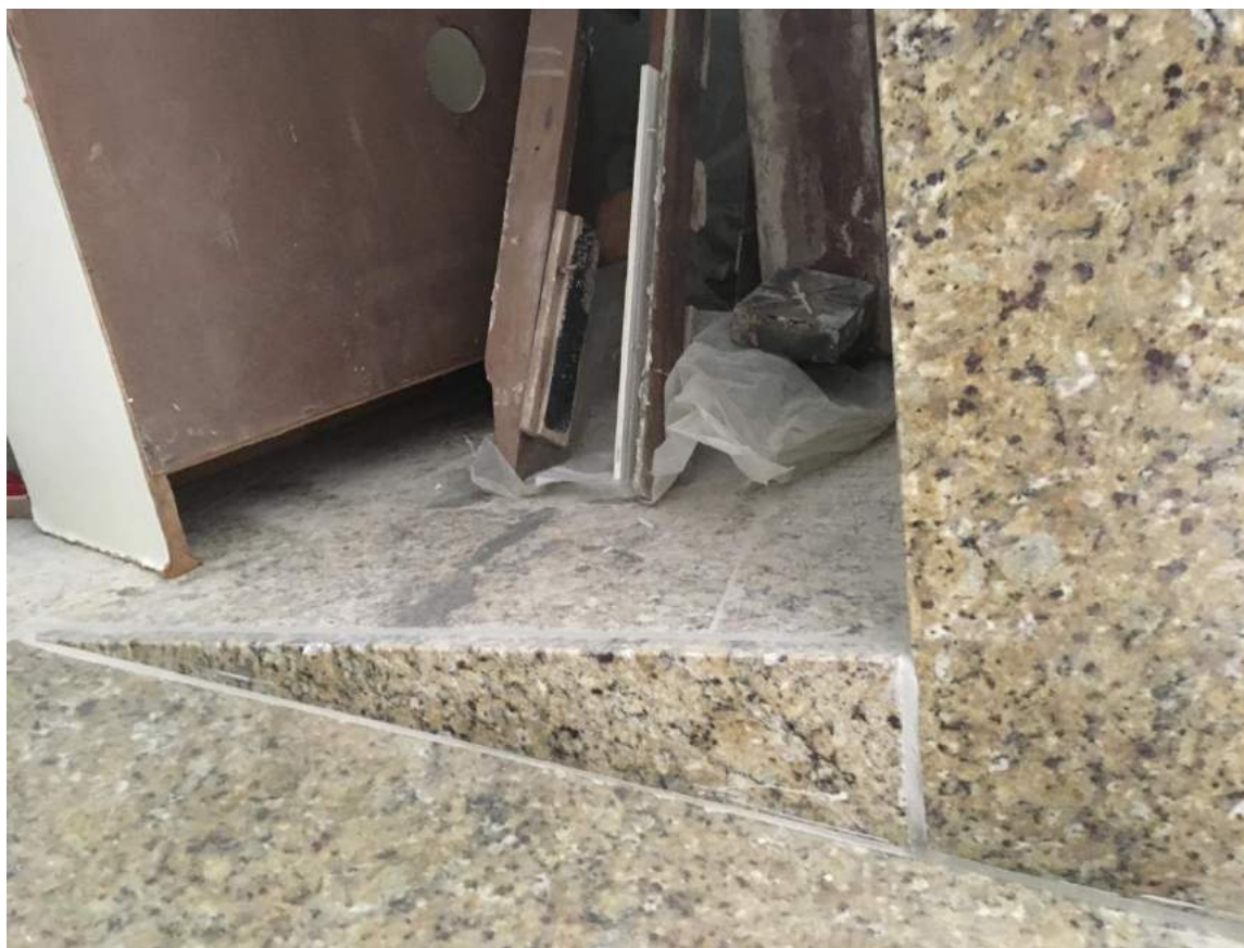
Figura 64 – Detalhe para o recorte realizado para a lateral da rampa
