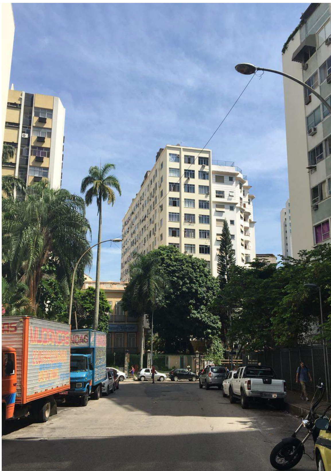
Figura 39 – Conclusão da inspeção, retirada e recomposição de todo o revestimento mal aderido juntamente da pintura da fachada frontal e lateral direita
