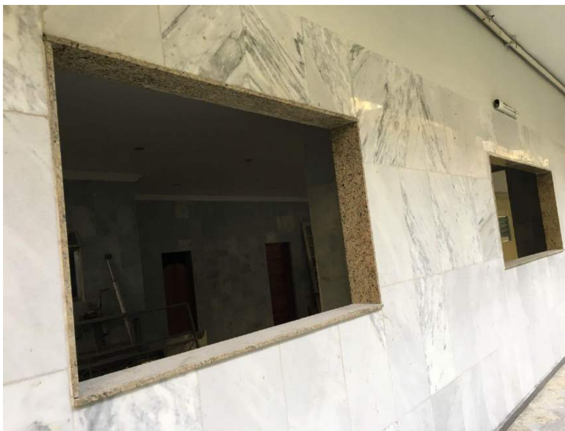
Figura 51 – Conclusão do arremate do vão aberto
