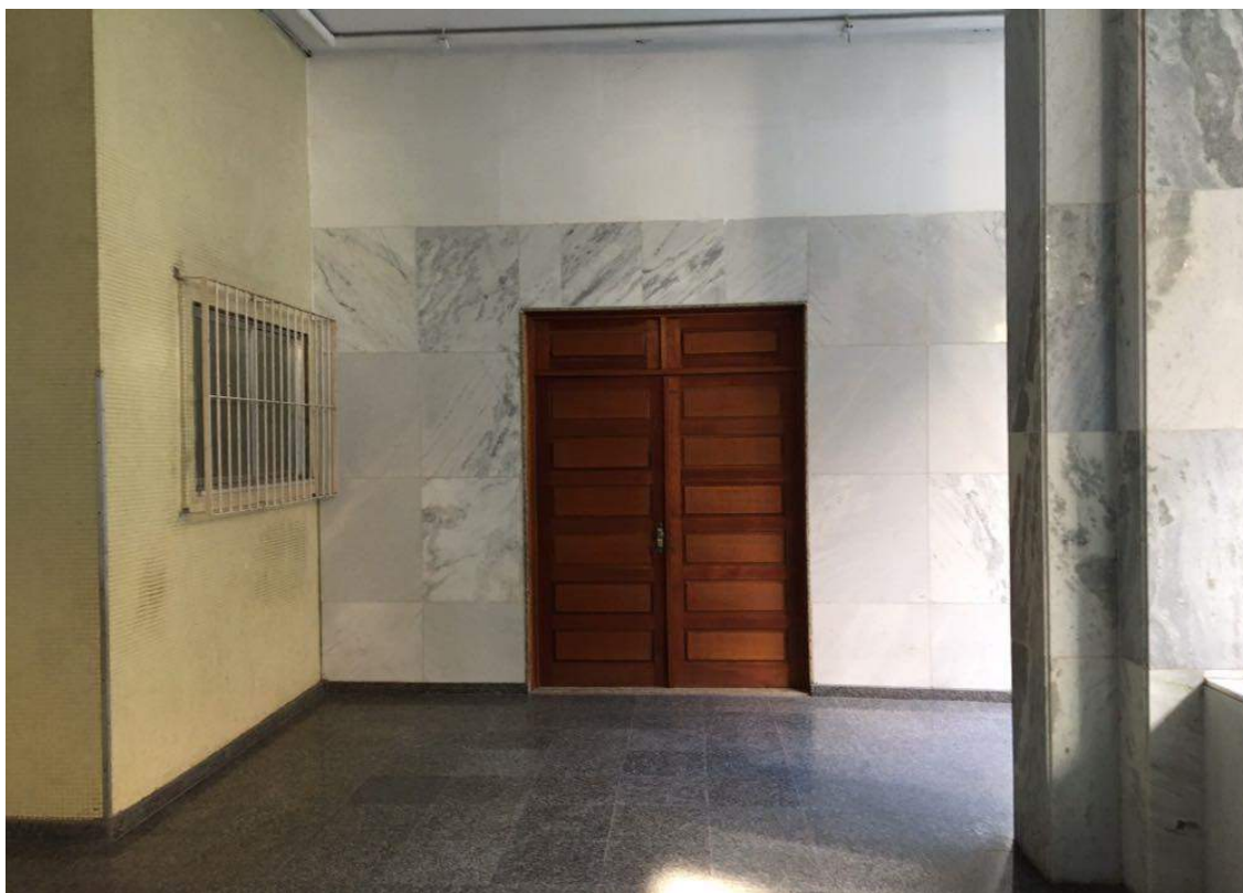
Figura 40 – Vista inicial da futura área de passagem nível térreo
