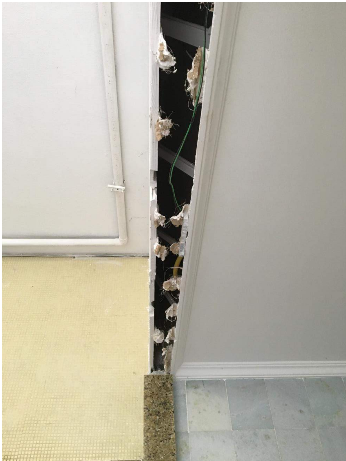
Figura 61 – Arremates de gesso a serem realizados com a retirada da porta
